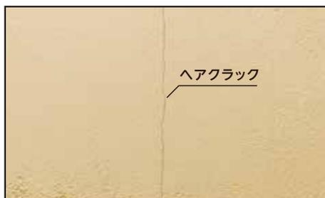
0.1mm以下のヘアクラックについては、S0（補修専用材）を使用し、水を使わない簡易補修を行います。
