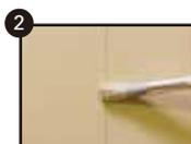
2 筆や細い刷毛にS0を付けて、クラックが見えなくなるまで、刷り込むように擦り付けます。もしくは、指先にS0を付けて優しく擦り入れてください。
