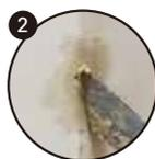
2 ペインティングナイフやコテを使って、欠けた箇所に練ったS0を埋め込みます。(片側ずつ材料を埋め込むと角を作りやすくなります。)
