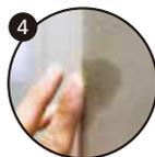
4 周囲と馴染ませるように指先で軽く撫でるようにします。(すぐに手洗いをしてください。肌の弱い方は、薄手のゴム手袋などを使用してください。)
